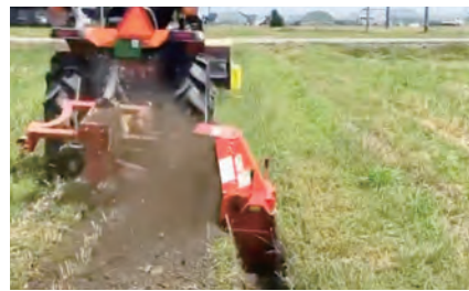
写真1=溝堀機による明渠の施工
